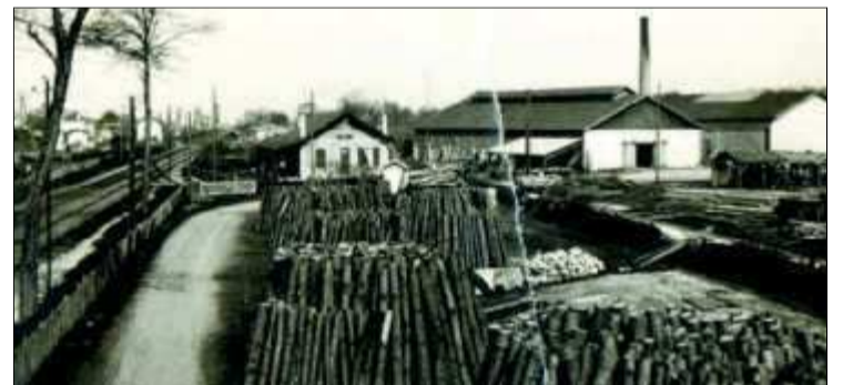
L'ancienne propriété d'une famille Billard vient d'être démolie pour laisser place à un parking. PHOTO COLLECTION PRIVÉE RAYMOND LAFARGUE
